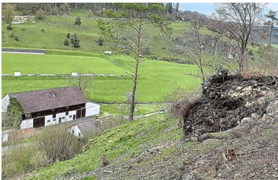
Felssicherung: Es wird ein Fangzaun im Bereich Maria-End-Weg in Altendorf errichtet, um die Felssteine im Wurzelstock einer umgestürzten Buche abzusichern und beim Ablösen aufzufangen. Foto: Geiger
