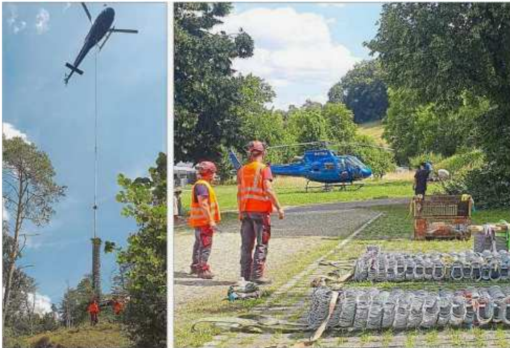
Ein Helikopter hat bei Altendorf Zaunmaterial in das unwegsame Waldgelände geflogen. Dort wird ein Felsschutz errichtet. Fotos: Mittl
