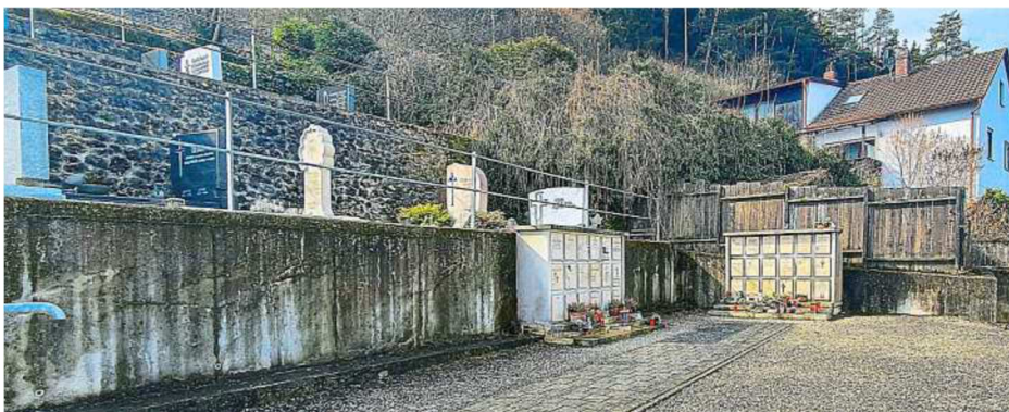
Auf dem Friedhof in Mörsnsheim wird eine neue Urnenwand eingerichtet. Foto: Geiger
