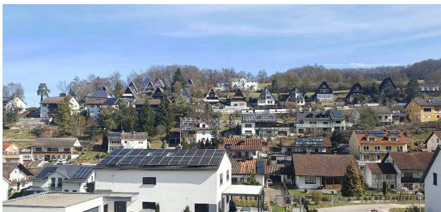
Die Schwedenhäuser und weitere Gebäude am Plattenberg in Mühlheim erhalten eine Druckerhöhungsanlage für die Wasserversorgung. Foto: Geiger
