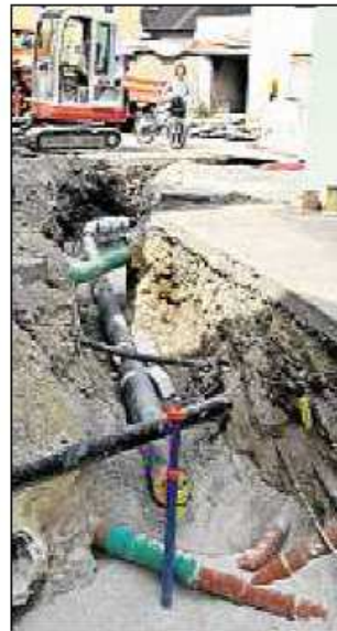
Die Baustelle „Innerer Markt“ wird derzeit gleich von drei Firmen belegt: Eine hebt die Gräben aus, eine legt die Wärmeleitungen und die dritte beginnt mit dem Ausbau des Asphalts und dem Setzen der abgrenzenden Einzeiler. Da hat eine Rollator-Fahrerin schon mal Mühe, durchzukommen (oben). Bürgermeister Richard Mittl informiert sich regelmäßig über den Stand der Arbeiten (unten links). Der Untergrund bietet ein buntes Gewirr an Rohrleitungen (unten rechts).
